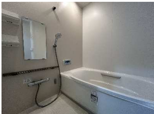
給排水及び浴室等改修工事（碧南北分署）
