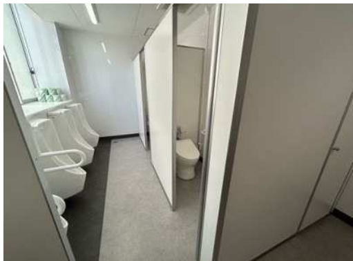
給排水管ほか保全更新工事（安城署）
