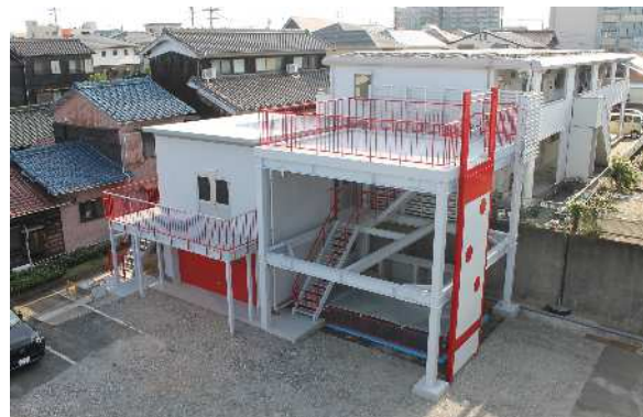
訓練施設新設工事（高浜署）
