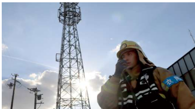
消防救急デジタル無線
