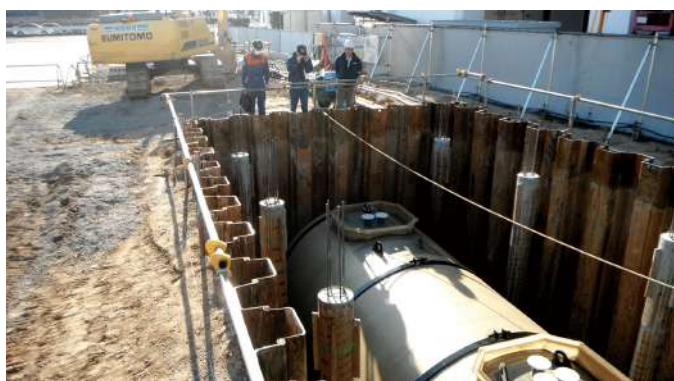
地下タンク検査
