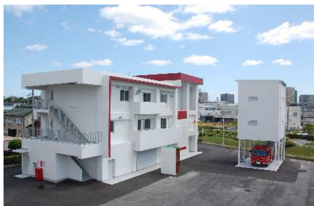
訓練塔建設工事（安城署）
